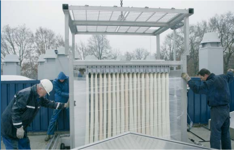
Zenon-Mitarbeiter installieren eine Membrankassette zur Abwasserreinigung
